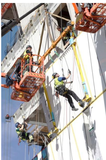
Erhvervsclimber fra firmaet Danclimb, som monterer facaden på Bella Sky Comwell.
